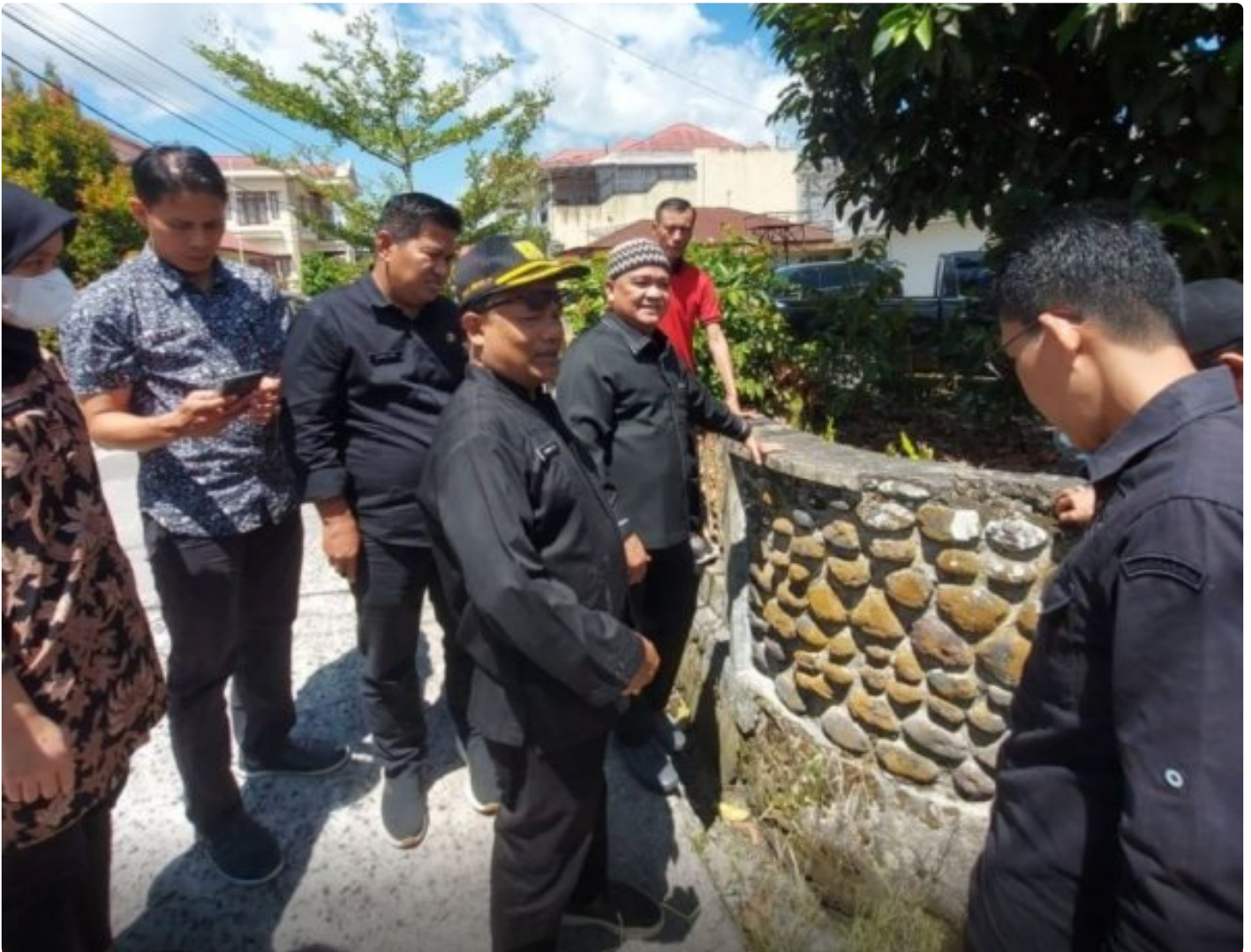
Pemko bersama DPRD Bukittinggi Tinjau Lokasi Rawan Longsor di Kelurahan Blaba ABTB
